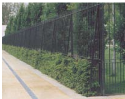
hekwerk in haag
