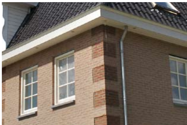
Metselwerk dominant, incidenteel stucwerk mogelijk
