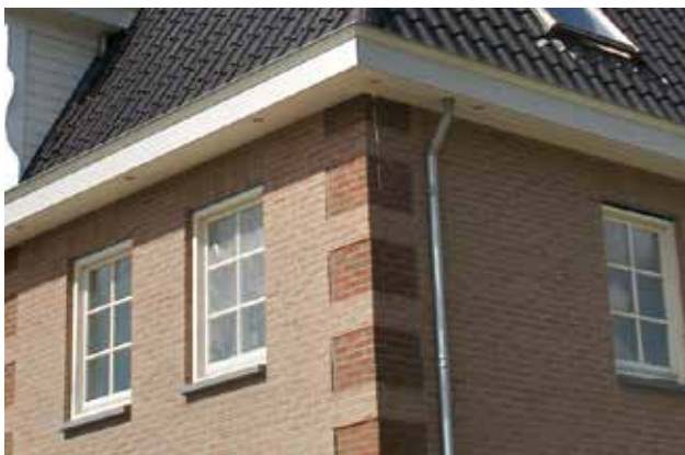
Metselwerk dominant, incidenteel stucwerk mogelijk
