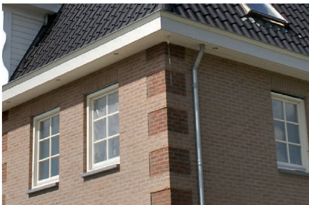
Metselwerk is dominant, incidenteel stucwerk mogelijk
