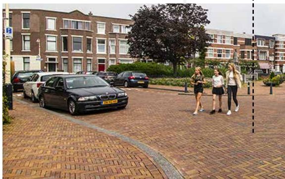
bestrating plein Haagse mix rode gebakken pavonia klinker met toevoeging van geel- en grijs tinten in aansluiting op gevel Vroondeal
