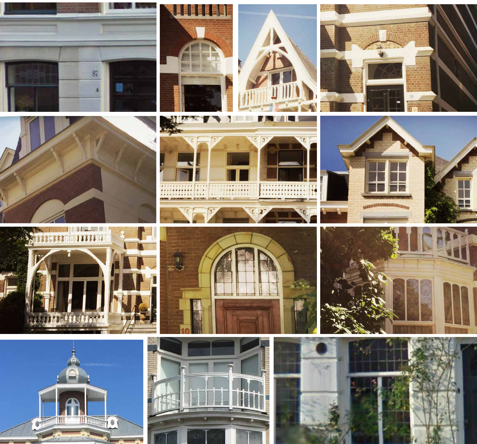
Dakvormen en zorgvuldige detaillering met witte-lichte elementen; houten kozijnen, dakranden, plint op de bg, erkers, dakkapellen, speklagen en ontlastingsbogen.
