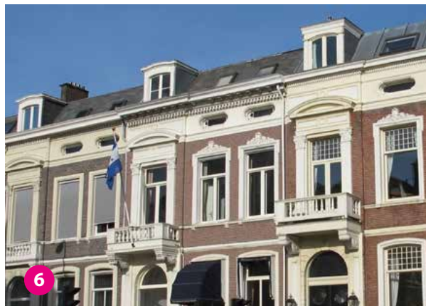
'Verticale' dakkapellen, geplaatst op de daklijst
