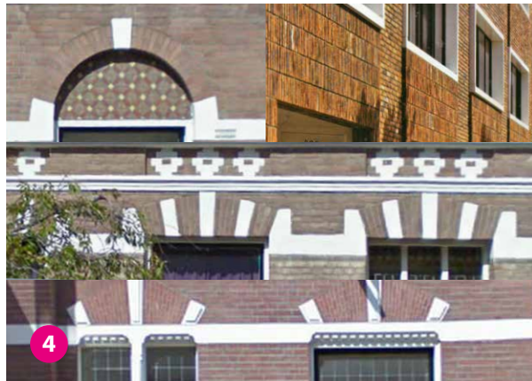
Rond gemetselde ontlastingsboog/latei uitgevoerd met witte detaillering. Of detaillering boven kozijn en deuren met ander metselverband.
